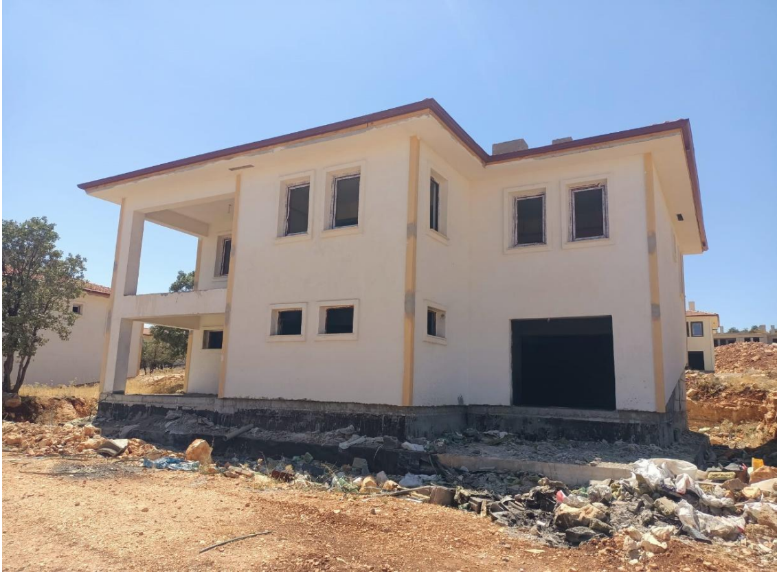
Şekil 6. Yapılmakta olan İki katlı konutlardan bir görünüm [Kömür (Komer)-Adıyaman].
