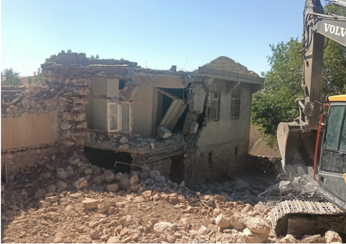
Şekil 2. Depremden sonra ağır hasar raporu verilen bu evde evin bir kısmı depremden kısa süre sonra yıkılmıştır. Görüntüdeki eklenti gerek yaşamsal faaliyetler gerekse hayvancılık faaliyetlerin devamı maksadıyla 10 Temmuz 2025 tarihine kadar kullanılmıştır.
